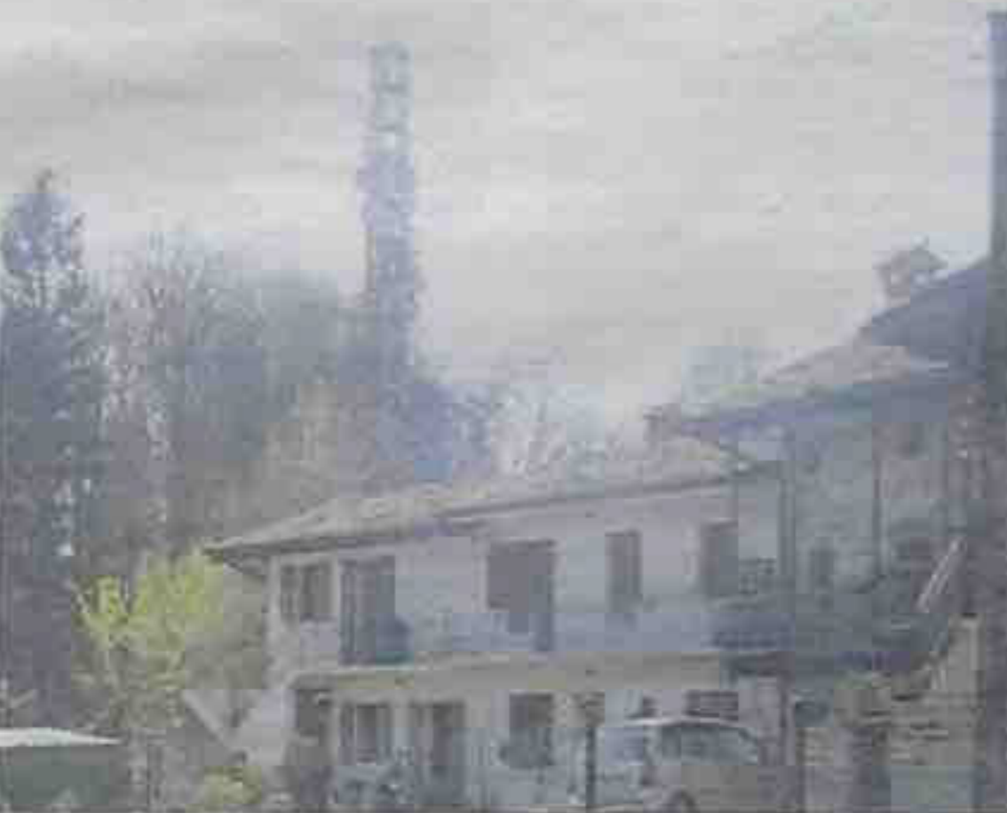
Il traliccio con i ripetitori di telefonia mobile a Monte di Buja
